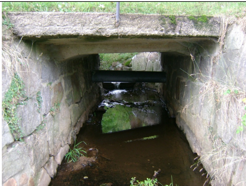
Fot 8 – Widok przepustu P4
