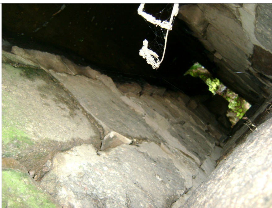
Fot 7 – Widok przepustu P2
