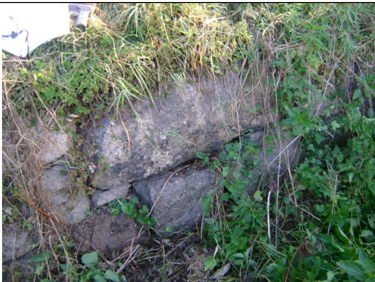
Fot 1. – Mur M1 - widok odcinka w km 0+103- 0+170
