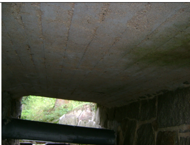
Fot 9 – Widok płyty nośnej przepustu P4
