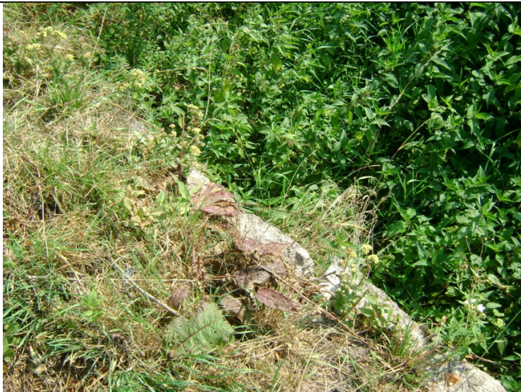
Fot 6 – Mur M4 – luźne elementy kamienne muru , zakrzaczenia w rejonie muru
