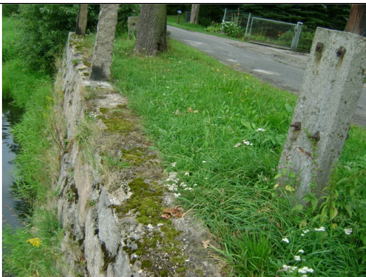
Fot 2 – Mur M1/2- widok lica muru
