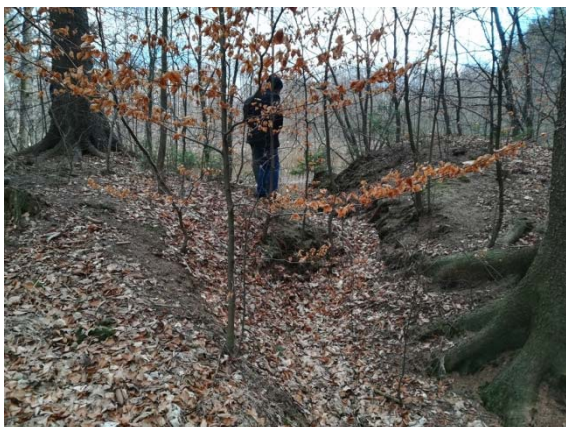
Fot. 4 Budowla upustowa - przelew stały
